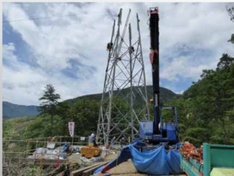
栢洞線 鉄塔組立作業
