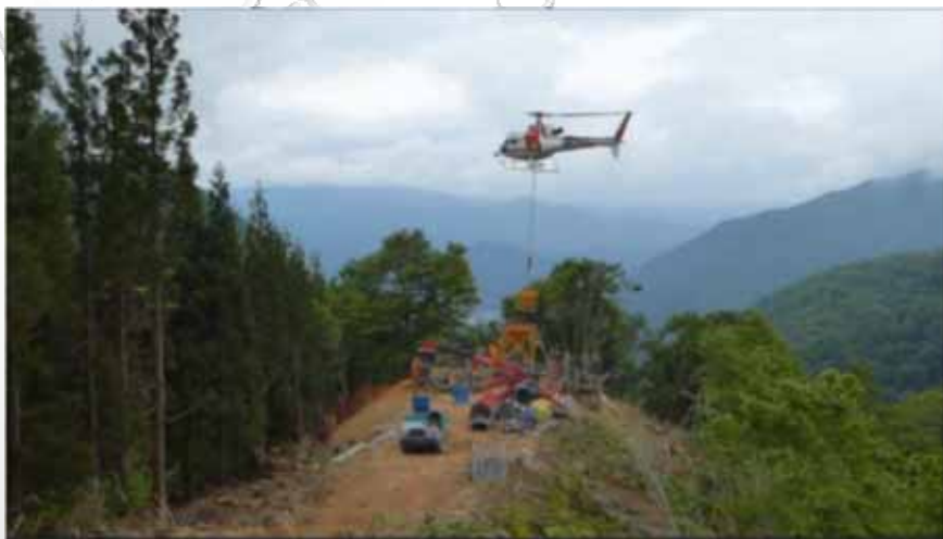
栢洞線 鉄塔基礎生コン打設
