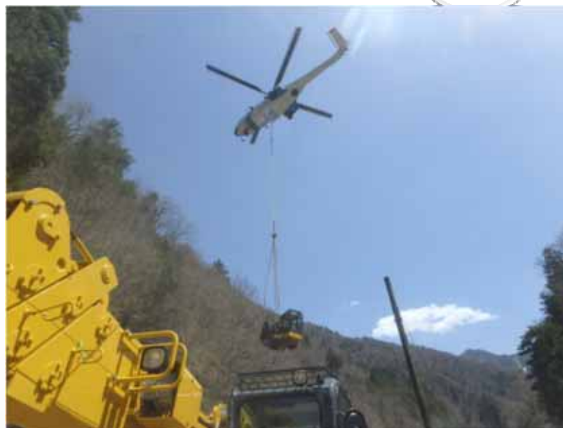
ヘリによる重機搬送
