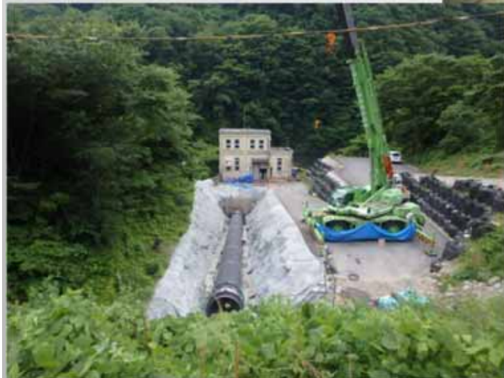
水圧鉄管更新埋設
