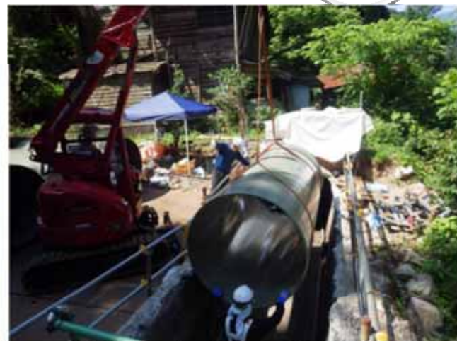
導水トンネルFRPM管搬入
