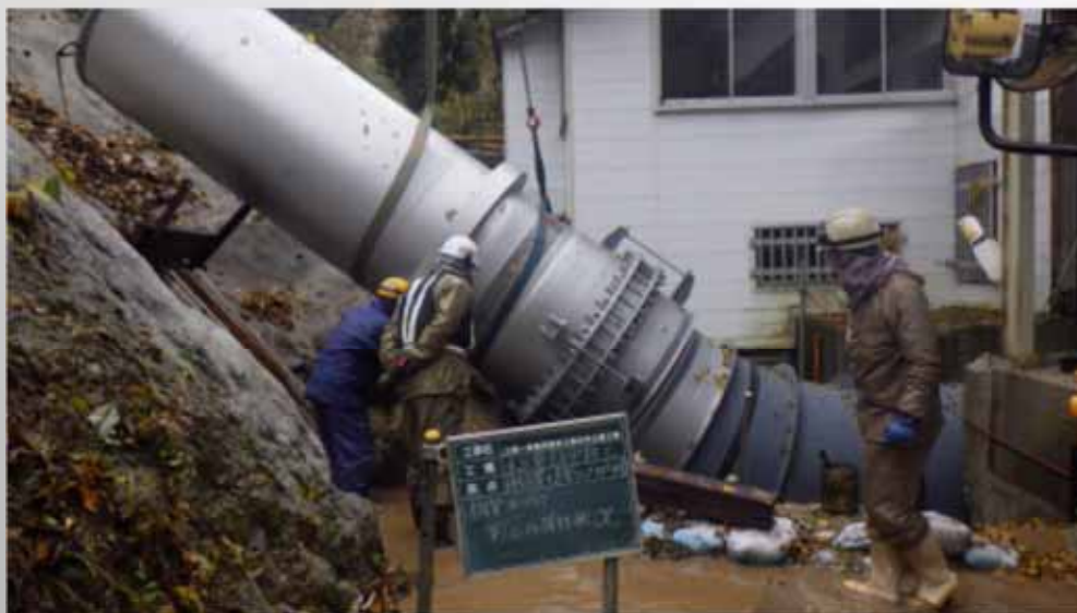
水圧鉄管工事施工
