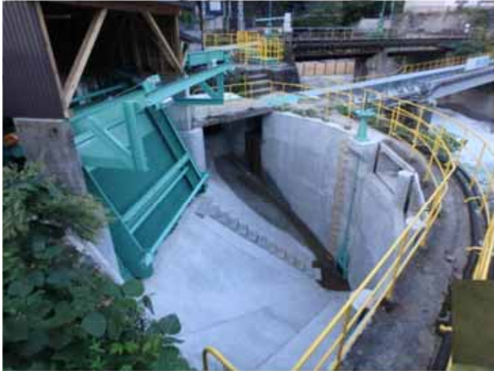
沈砂地と除塵機完成
