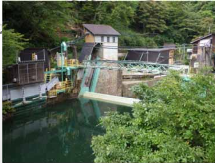
取水設備完成
