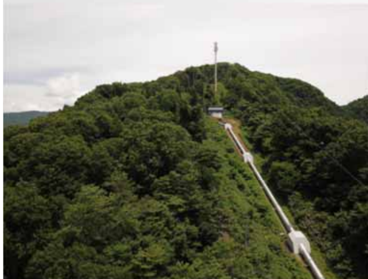
水圧鉄管完成
