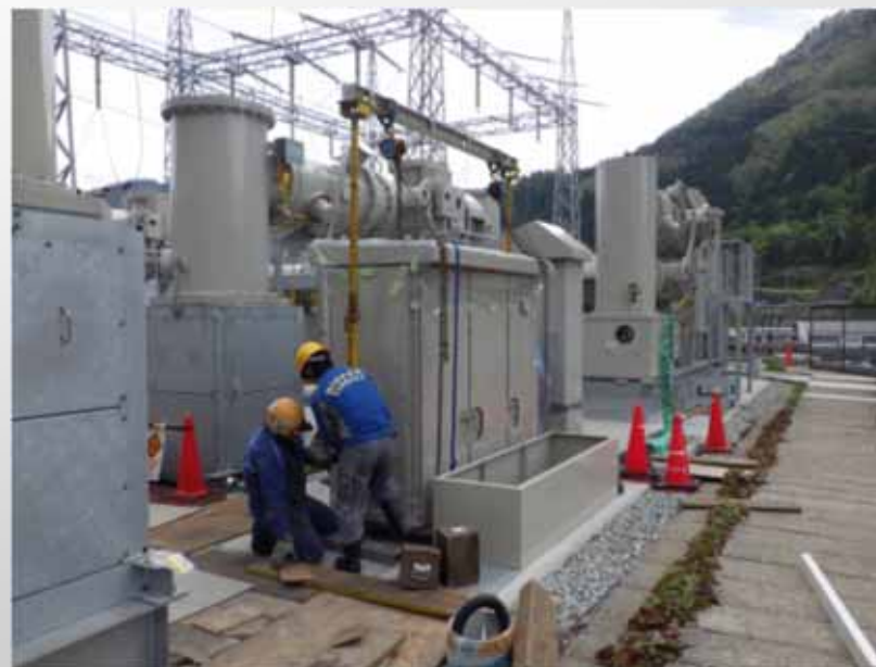
池ノ上第二変電所新設工事
