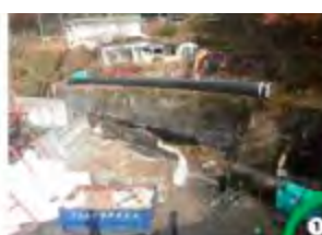
①搬入→1本10mのパイプが 続々と運ばれます
