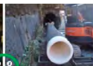
②融着→パイプを融着すること で長尺化します
