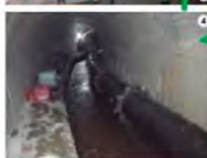
④引き込み完了
