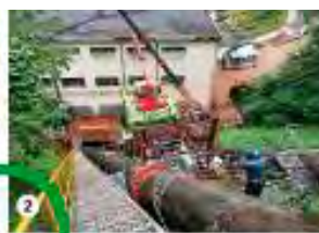
②急斜面にクレーンを設置
