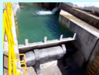
取水堰堤（倒伏堰）
