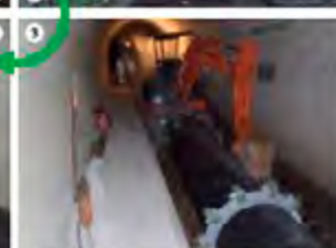
③引き込み→バックホウを使って 引き込みます
