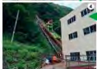
④水圧管布設工事
