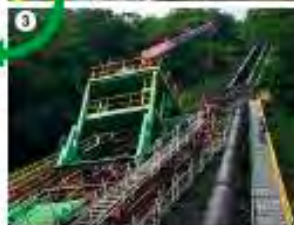
③水圧管布設工事準備中
