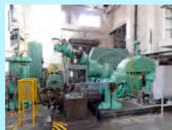
水車発電機更新
