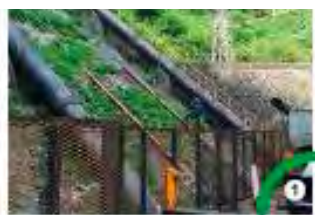
①急斜面に架台を設置
