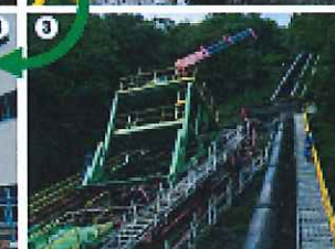
③水圧管布設工事準備中
