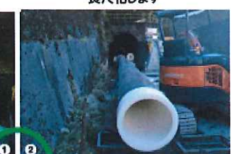
④融着→パイプを融着することで長尺化します
