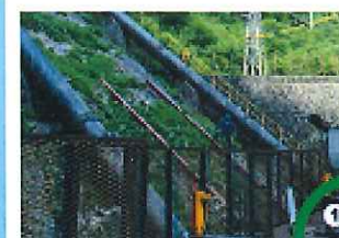
①急斜面に架台を設置
