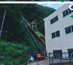
④水圧管布設工事
