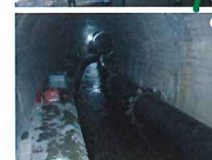
④引き込み完了
