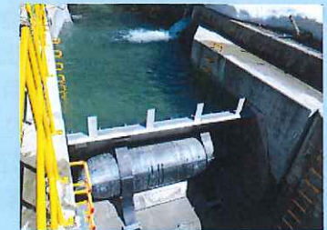
取水堰堤(倒伏堰)
