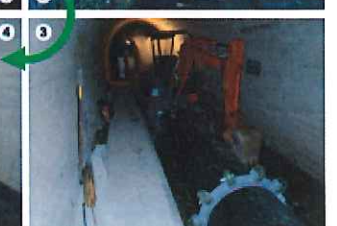
③引き込み→バックホウを使って引き込みます
