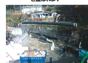
③搬入→1本10mのパイプが縦々と運ばれます
