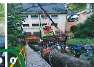
②急斜面にクレーンを設置
