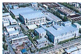
ニチハマテックス株式会社習志野工場様 主要製品: 外壁材モエンエクセラード 所在地: 千葉県習志野市東習志野
