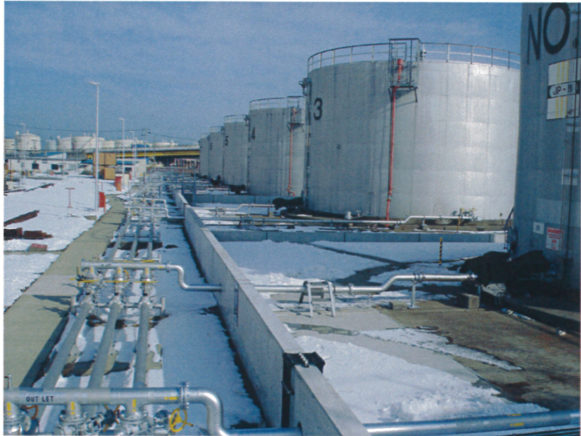
防油堤改修に伴う配管更新工事
