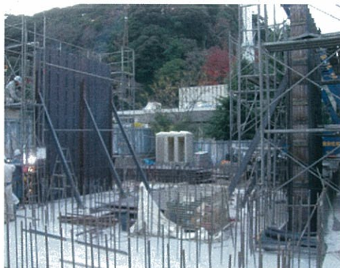
放射線遮蔽鉄板施工現場
