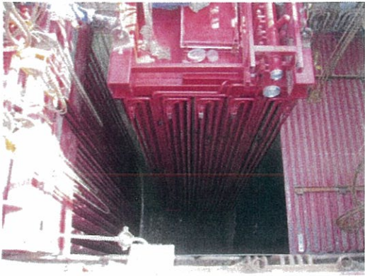
ボイラーチューブ装着風景
