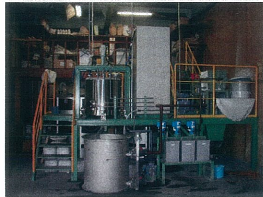
土壌浄化材開発試験設備
