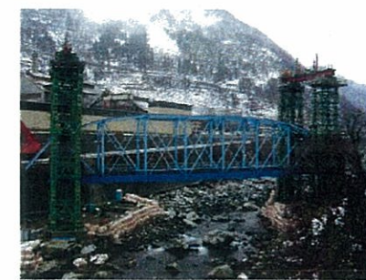
ジャッキダウン方式による荷降ろし状況
