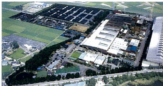
日本鑄鉄管株式会社殿
