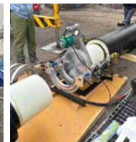
バット融着での施工状況
