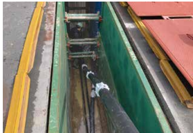
パイプインパイプ施工(WED-13.6 W100)
