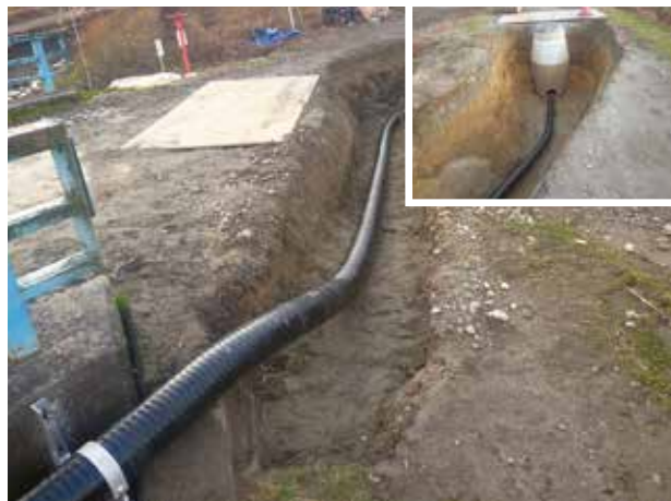
橋梁埋設部(GNGWDA W75)
