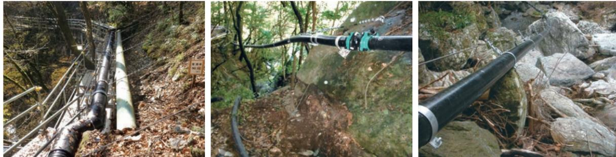
配管ルートがない場合等は既存の岩を利用したワイヤーでの吊りや補助固定
