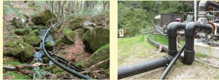
本工事は、豊富な湯量を誇る土湯温泉で、温泉増湯用およびバイナリー発電冷却水用配管として MESCO パイプを採用いただいたものです。傾斜のきつい斜面を縫うように配管された状況と、荒川上空に張られた吊配管を眺め、改めて MESCO パイプの凄さを実感できる現場でありました。因みに表紙写真は、約 200kg の減圧槽を7名で斜面約 500mをほぼ人力運搬し、精魂尽き果てた時の記念写真です。今回の計画は、ポリエチレン管 150A、200A× 約 3,500mを高低差約 400mある山岳へ布設するものです。工事は6月中旬より着工し、約3か月で通水まで完工することができました。発注者である湯遊つちゆ温泉協同組合様へは、各種申請などご協力いただきましたことを、まずは感謝申し上げます。
