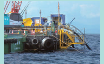
パイプ繰出し
