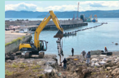
パイプの陸揚げ
