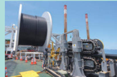
パイプ繰出し
