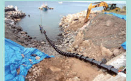
防護管の取付
