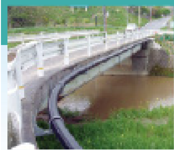
異型管なしでカーブのついた橋に添架できます。
