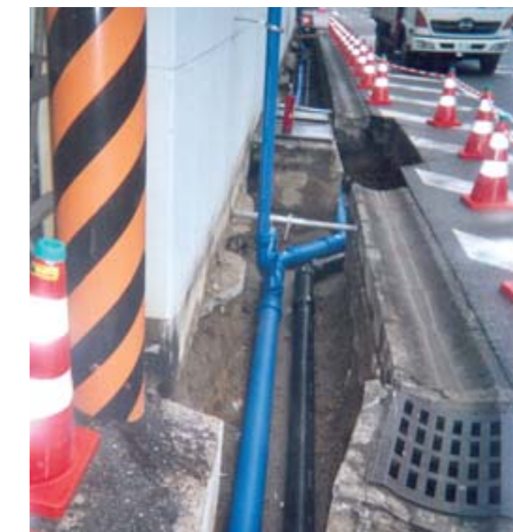
当社製品WEETA-13.6（アラミドがい装ポリエチレン管）と水道配水用ポリエチレンパイプを納入いたしました。
