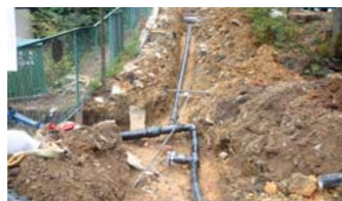
当社製品WEETA-13.6（アラミドがい装ポリエチレン管）と水道配水用ポリエチレンパイプを納入いたしました。
