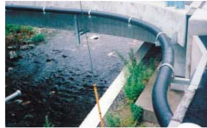
凍結防止 品種：GNGW 呼び径：W100 長さ：77m
