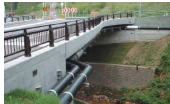
凍結防止 品種：SP(PE/PE) 呼び径：300/400 長さ：100m
