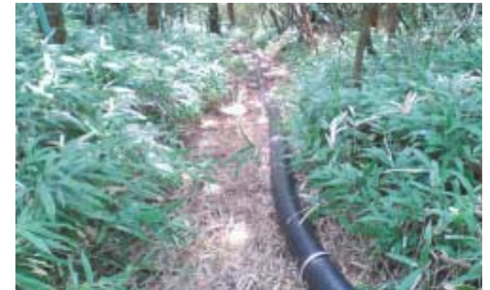
凍結防止 品種：GNGW-13.6 呼び径：W50 長さ：460m
