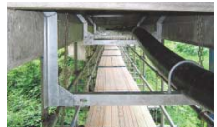
凍結防止 品種：GNGW-13.6 呼び径：W75 長さ：124m
