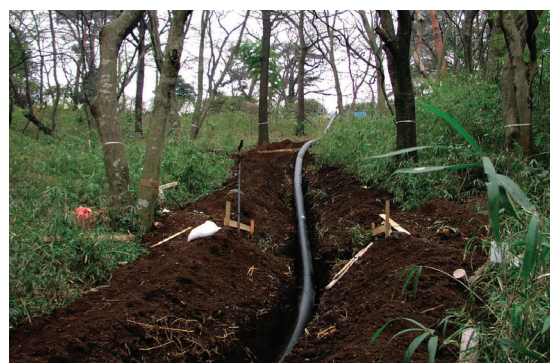
●下水道斜面配管●
