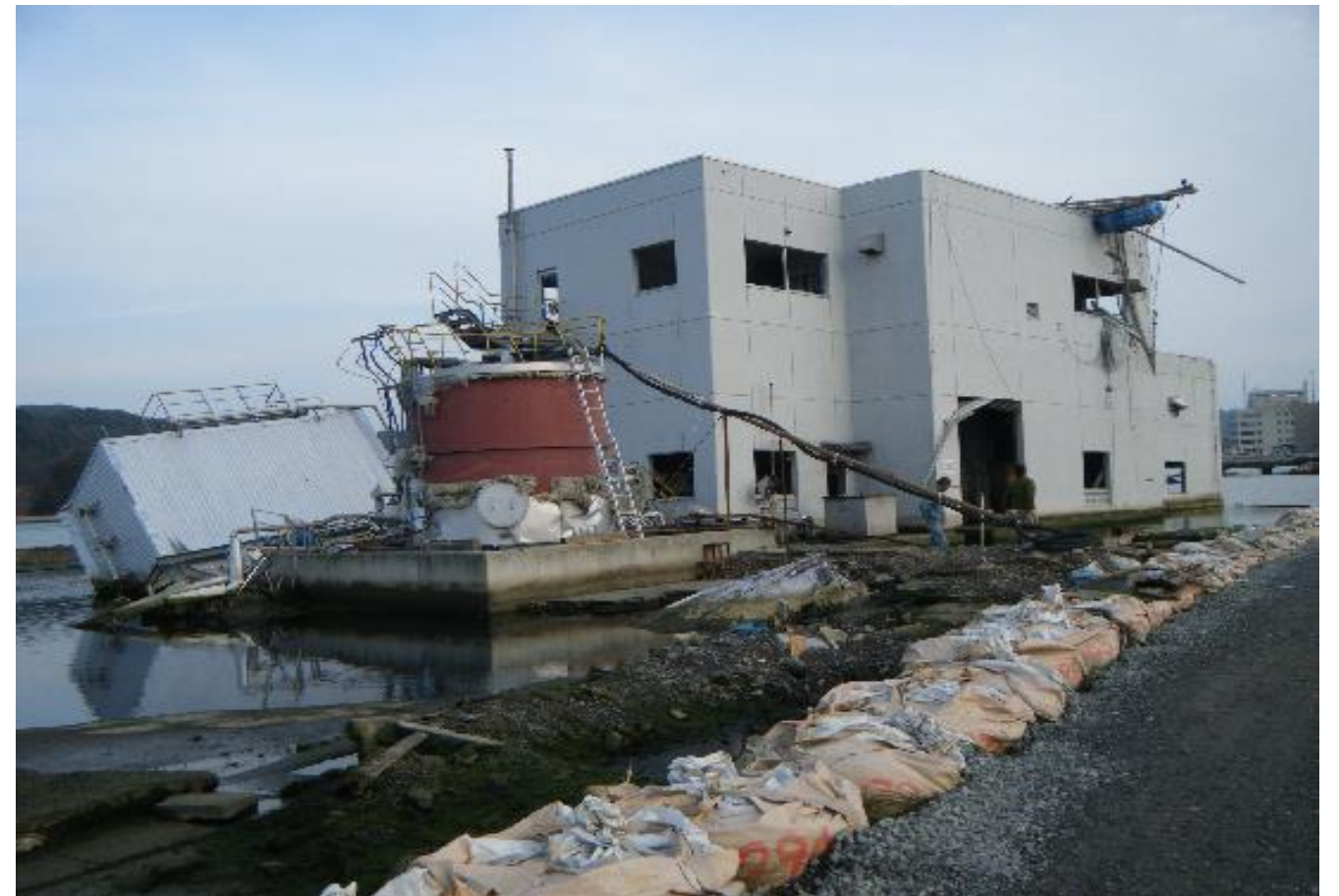
既存施設の被災状況
