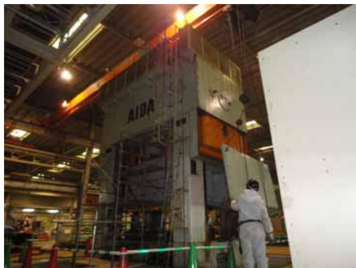
大型600tプレス機設置工事
