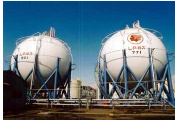
高圧ガス製造事業所
