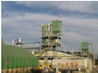
喜多方工場濾過材製造設備
