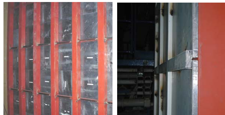
鉛パネル施工状況
