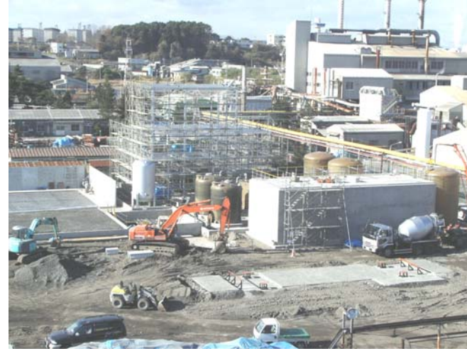
溶解飛灰脱塩設備
