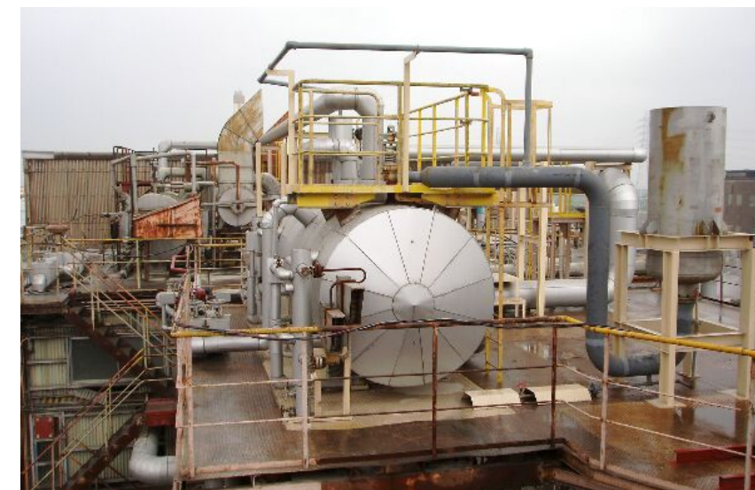
廃熱ボイラ 全景
