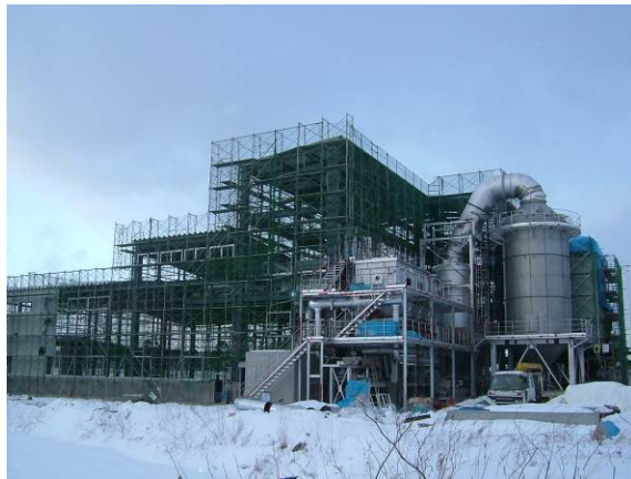
建設中の焼却施設
