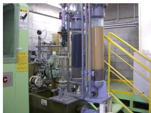
廃水処理設備
