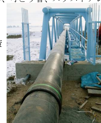
水管橋添架部
