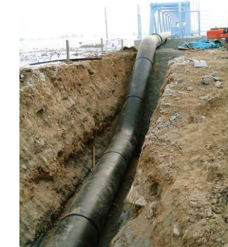
水管橋上流取付バンド部
