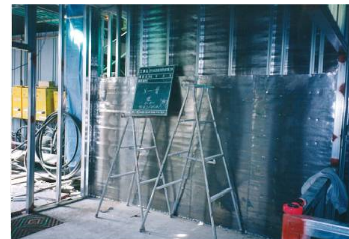
放射線防護工事
