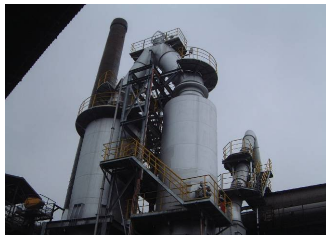
排ガス処理設備
