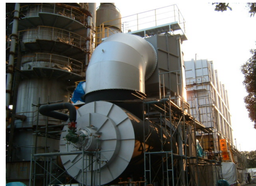
脱臭設備全景
