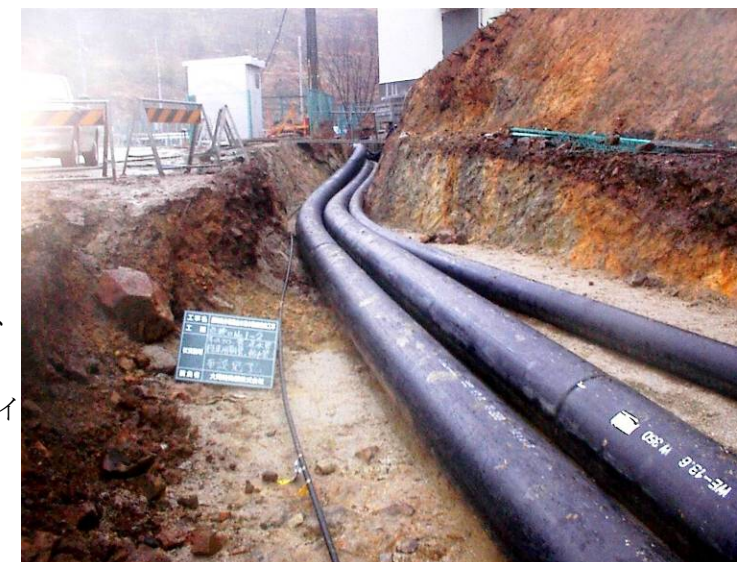
最終処分場 浸出水送水管
