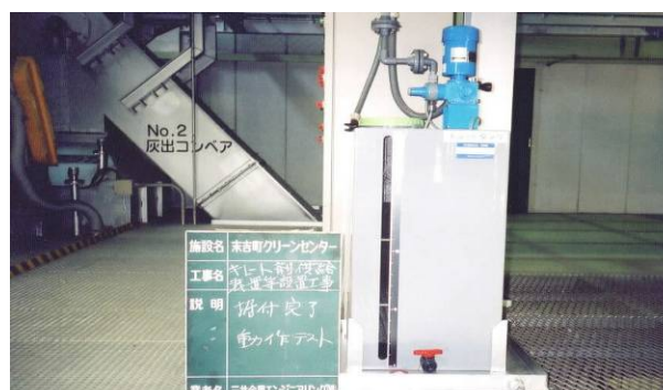
キレート剤供給装置
