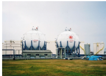
LPG貯槽全景
