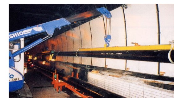
パイプ敷設作業状況
