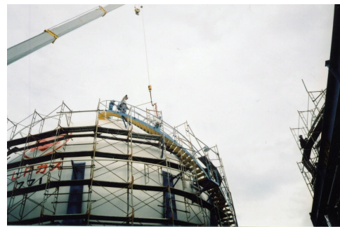
開放検査工事
