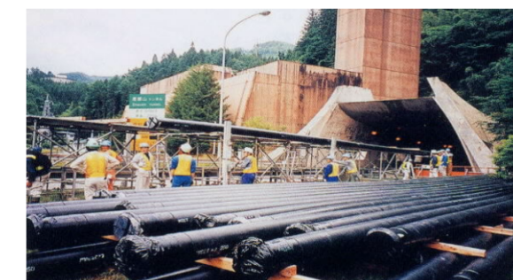
トンネル坑口パイプ積み作業状況
