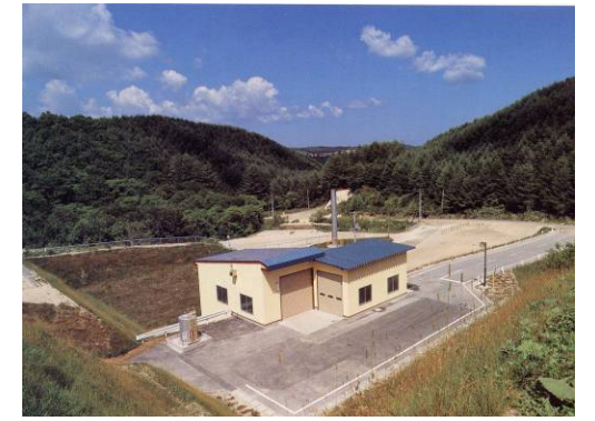
東藻琴村殿ごみ焼却施設
