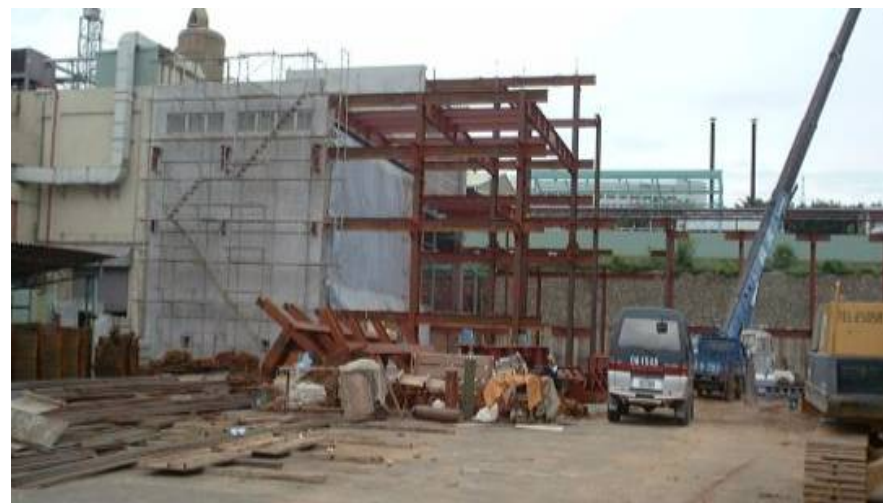
増設中の建屋
