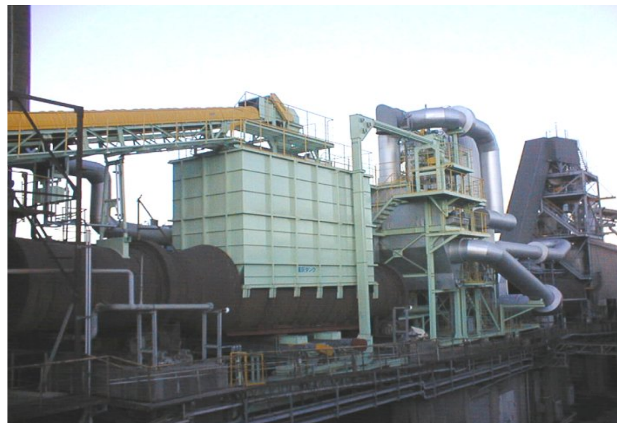
湿灰乾燥処理設備
