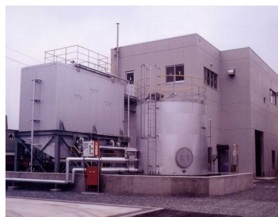
廃油処理設備施設
