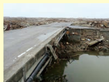
南相馬市農集排 (東日本大震災状況)
