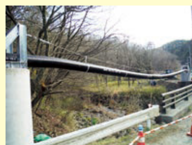
南三陸町水道吊り配管
