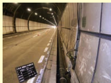
青葉山トンネル消火栓配管
