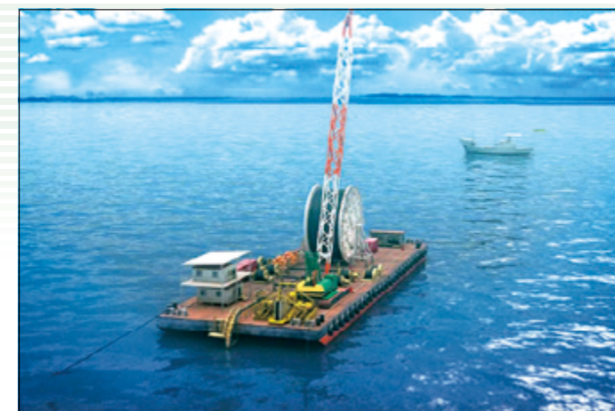
海底送水管布設状況
