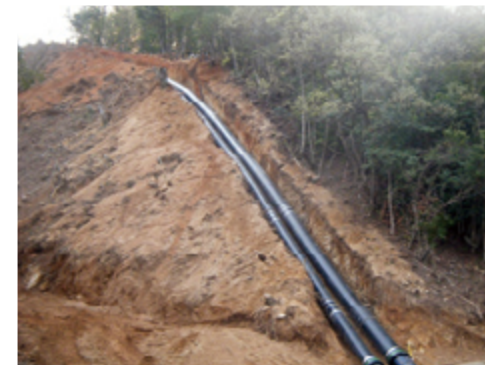
WEETA-13.6 W500、W600の急斜面配管
