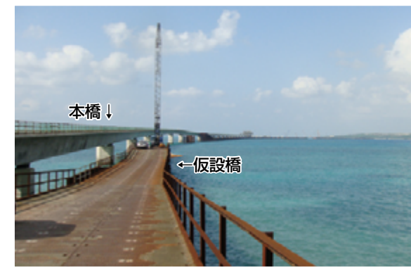
伊良部大橋全景
