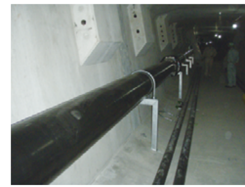
伊良部大橋一般橋梁部の内部添架状況
