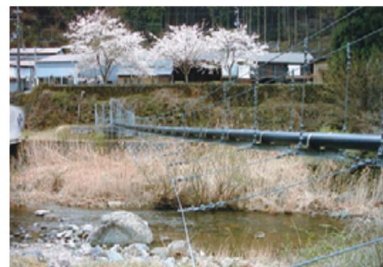
東北地方 軽量で吊り配管が基礎構造に負担をかけません
