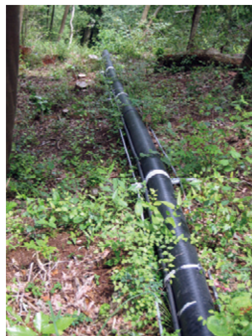
ワイヤーでサポートした急斜面での使用例 WEETM WEETA-13.6 WE 呼び径 W100 長さ 320m
