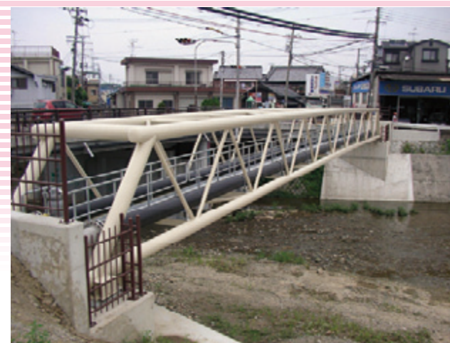
トラス橋との組み合わせ使用例 (ダブル配管) WE 呼び径 W300 長さ 29m×2ライン
