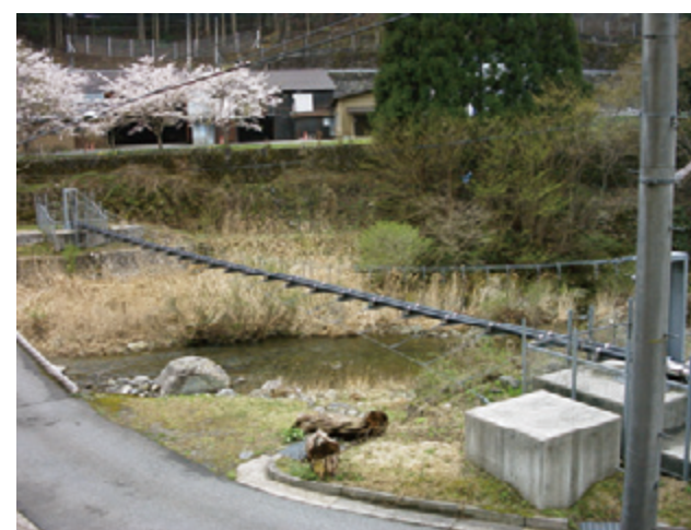
吊配管使用例 GNGW-13.6 呼び径 W75 長さ 61m×2ライン
