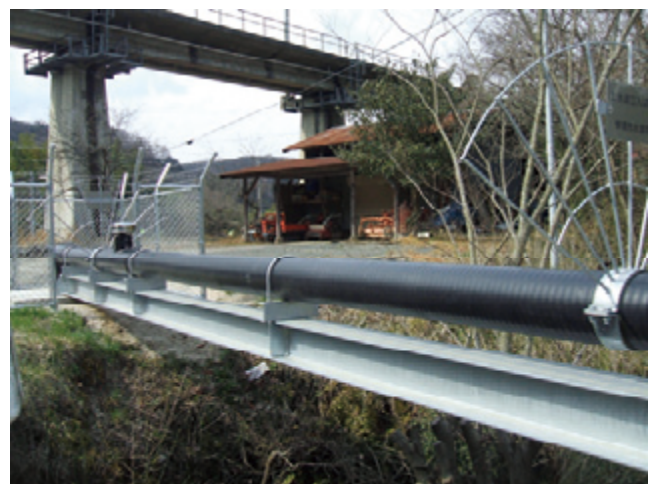
水管橋としての使用例 GNGWA-13.6 呼び径 W150 長さ 20m
