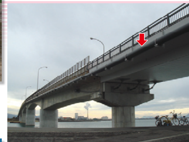
PC橋への添架例 WEETA-13.6 呼び径 W350 長さ 418m
