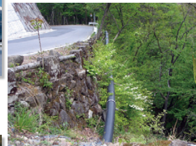
石積み擁壁への添架例 WE 呼び径 W150 長さ 160m
